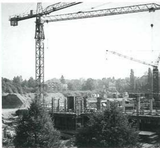
Blick auf unsere Baustelle
