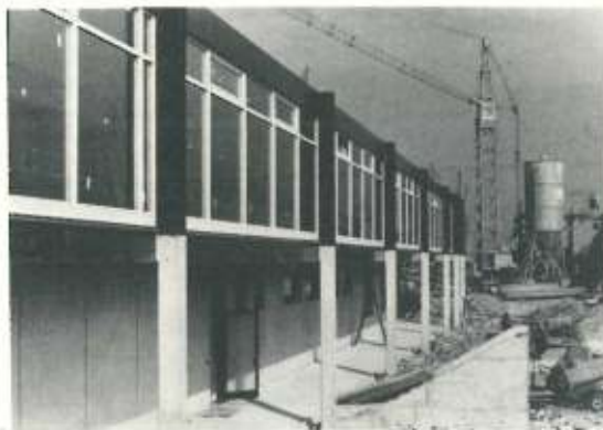
Im Osten angrenzend an das Wirtschaftsgebäude sind eine moderne Wäscherei und Werkstätten entstanden.
