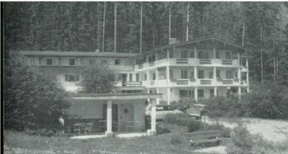
Mittelbau und Westflügel des Genesungs- heimes. Der Ostflügel ist im Bilde ver- deckt.
